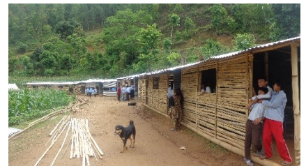
ネパール地震 仮設校舎建設。
